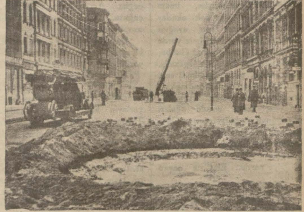
Atıldığı farsedilen bombaların sokaklarda açtığı çukur
